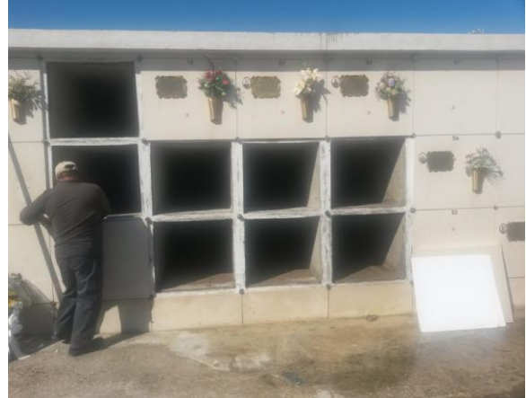
Recolocação de tampas de pedra
